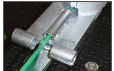
Appui large pour le bloc central, fers ronds soudés
