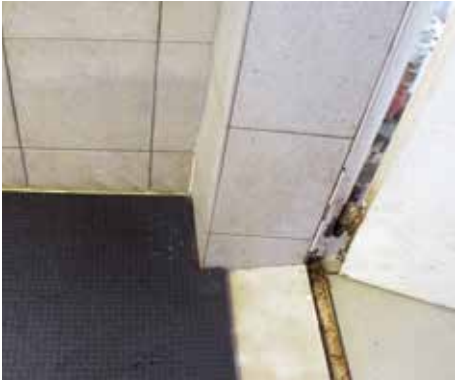
de nodige uitsparingen worden uit de matten gesneden
