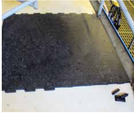
de niet benodigde puzzeldelen aan het einde van de mat worden afgesneden
