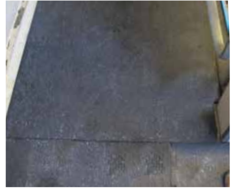
de niet benodigde puzzeldelen aan het einde van de mat worden afgesneden
