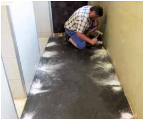
daarna worden de matten met spijkerpluggen bevestigd
