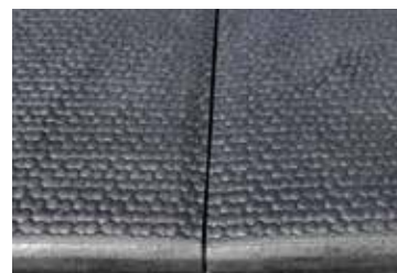
the mats are laid out edge to edge
