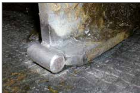
sivujalokset, joissa rautatanko ja leveä laakeri
