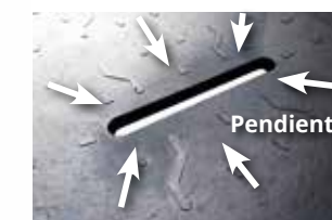
Los líquidos escurren hacia la ranura desde todas las direcciones
